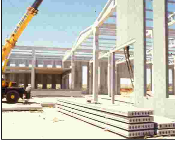
Döşeme Panelton Uygulaması
